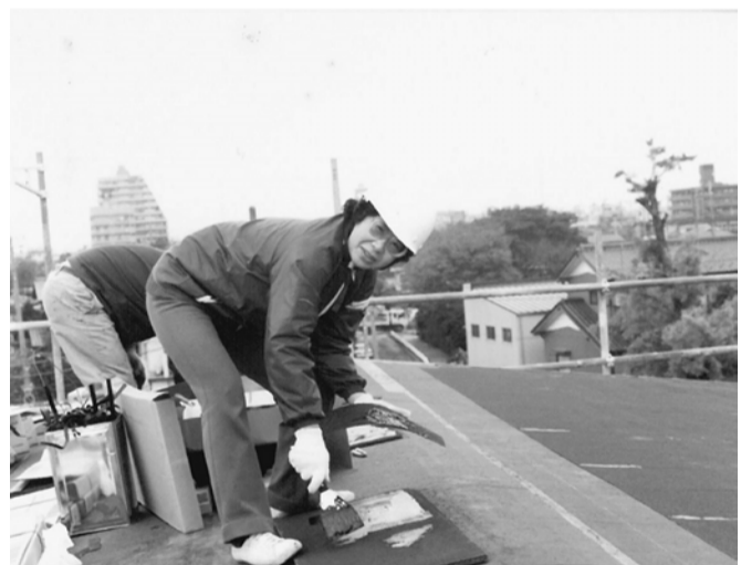
板金工事をする篠田綾子さん（1987年）
