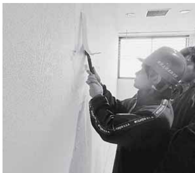
現場ではクロスをはがす作業を経験
